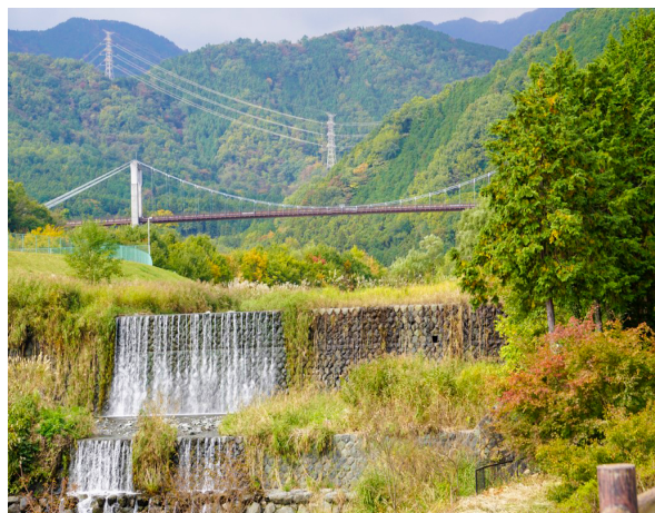
堤長 189 m の水無川戸川堰堤
